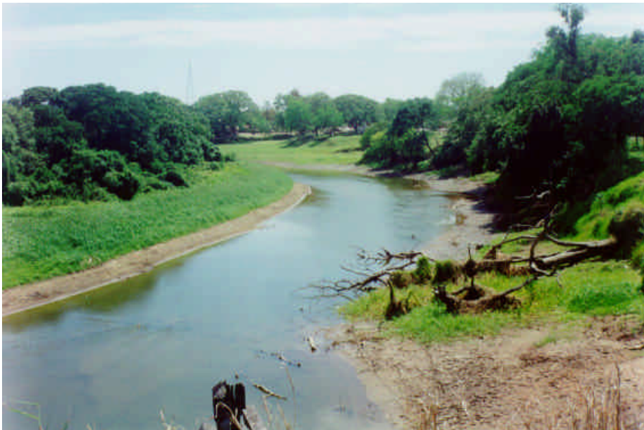
Río de Oro; mantener y conservar la vegetación de ribera es fundamental Para evitar la colmatación de importantes cauces. (Foto; Equipo de Suelos)
